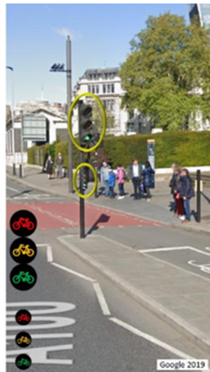
Figura 17 - Grupo focal com dimensões e altura menores para permitir a visibilidade a partir da linha de retenção. Fonte: Google - Londres, Reino Unido
