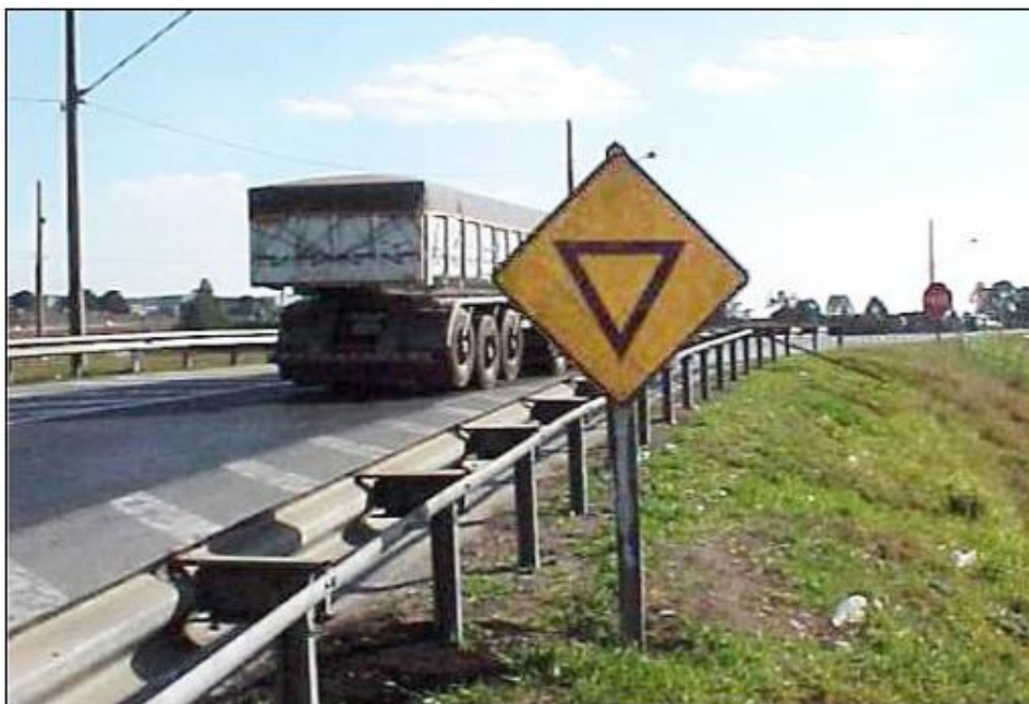
Figura 12 - Placa que estava instalada em uma rodovia paulista e que não existe no CTB ou nas Resoluções do Contran. Foi uma invenção. A menos que existisse uma autorização do Contran para sua utilização em caráter experimental (o que é pouco provável), essa placa estava desobedecendo ao princípio da legalidade.
