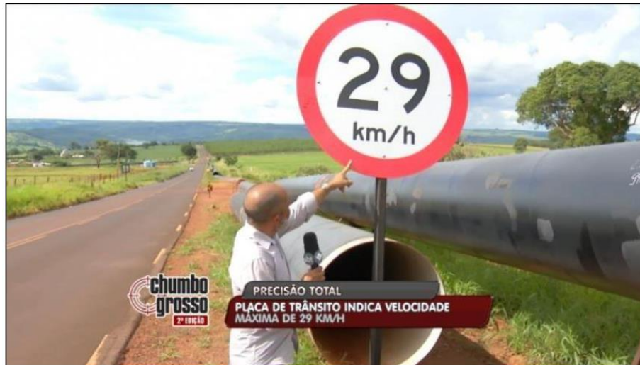
Figura 53 – Placa de regulamentação que desrespeita o CBT e provoca descrédito nos condutores.
