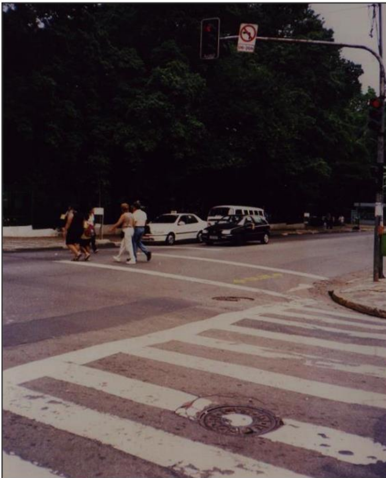
Figura 17 – Embora siga o Manual, a aplicação acima gerou uma despadronização, devido ao fato de que a faixa zebraada antiga não foi retirada antes da pintura da paralela. Possivelmente o pedestre poderá ter interpretações dúbias quanto à diferença de tratamento.
