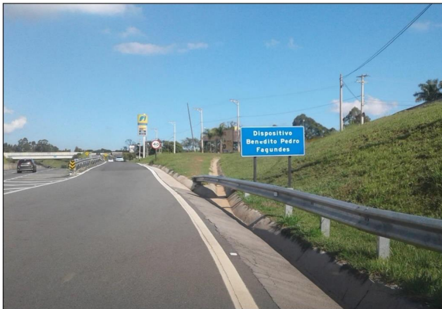
Figura 51 – Sinalização de indicação de um dispositivo.
