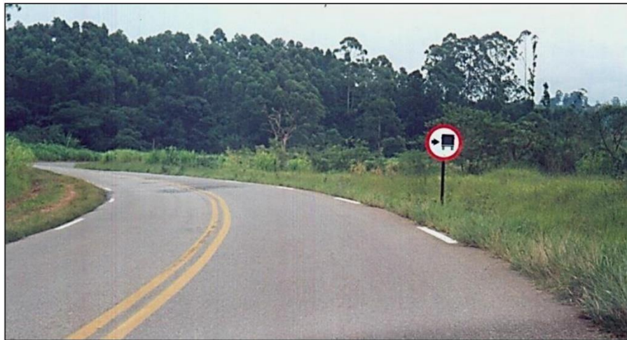
Figura 54 – Placa de regulamentação sem fundamento lógico.
