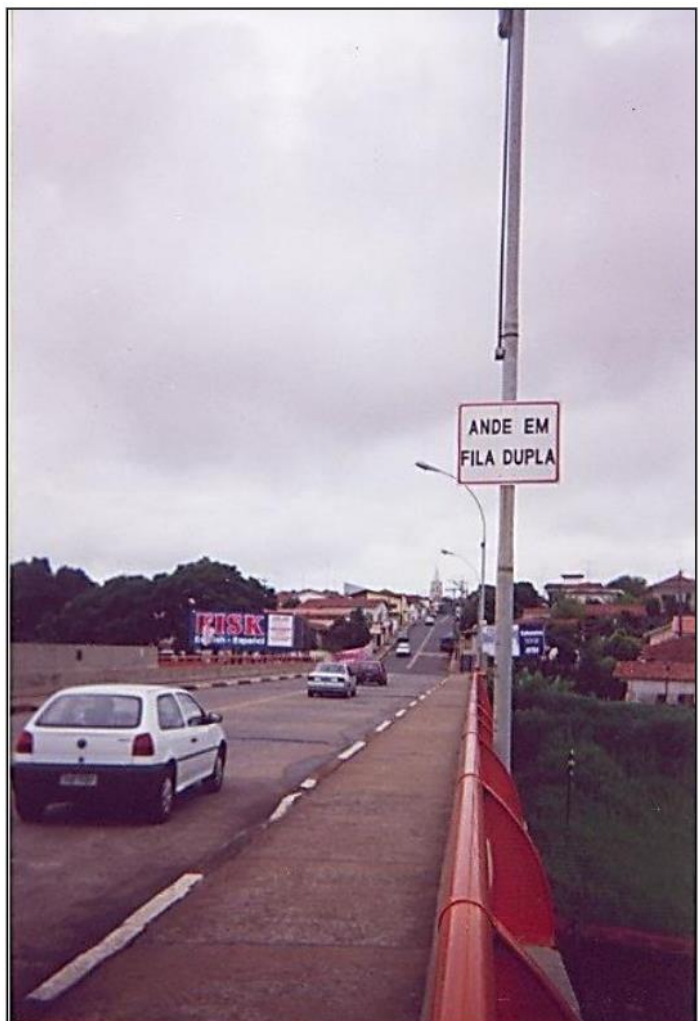
Figura 44 – Falta de clareza.
