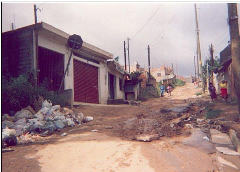
Figura 35 – placa R-1 em via sem pavimentação.
