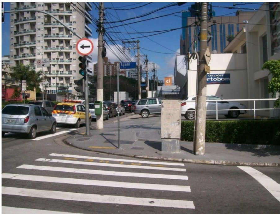
Figura 37 – Controlador semafórico obstruindo parte da faixa de pedestres.
