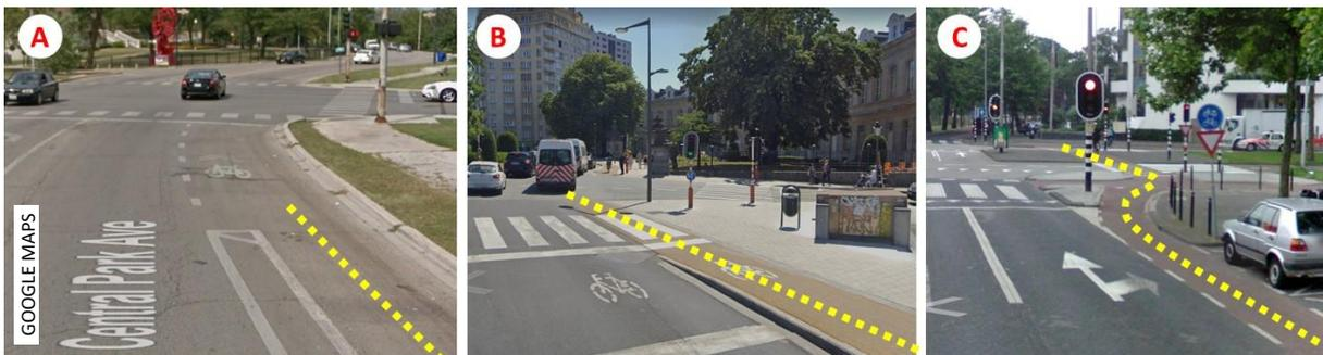
Figura 81: Desvios em interseções (linha amarela). Chicago, Estados Unidos: encurtamento da ciclofaixa pouco antes do cruzamento (A); Bruxelas, Bélgica: a ciclovia desce da calçada para o nível da faixa de rolamento (B); Roterdã, Holanda: a ciclofaixa é desviada para a calçada e uma ilha separa as bicicletas dos demais veículos (C).
