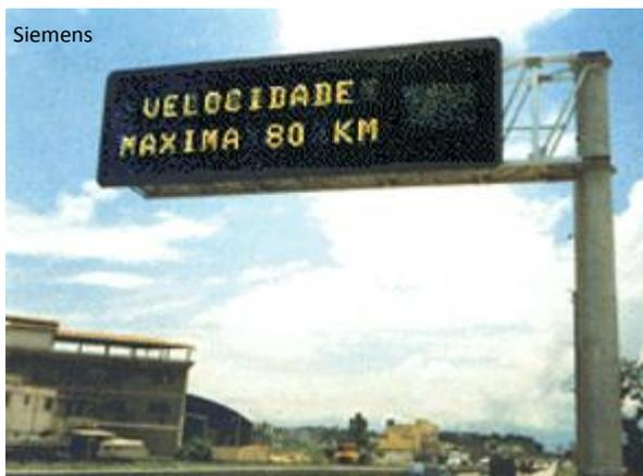
Figura 9 – PMV de LEDs
