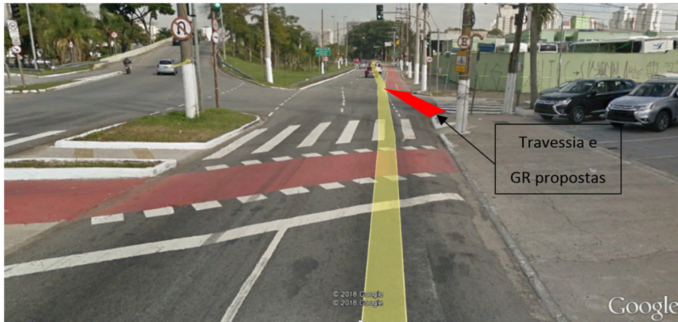
Imagem 18: Detalhe do cruzamento da Av. Olavo Fontoura com a Rua Brazelisa Alves de Carvalho
