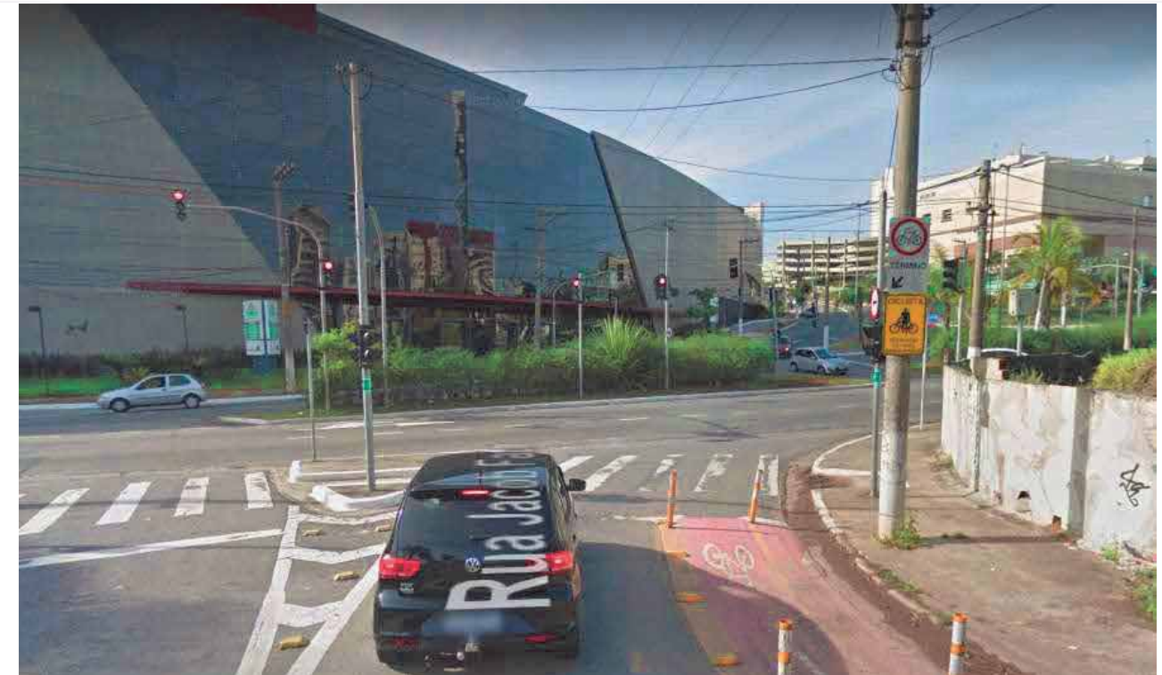
Foto 18: Cruzamento R. Jacob Fatah x Av. Regente Feiro - retirada no Google Street View –acessado em 15/05/2018.
