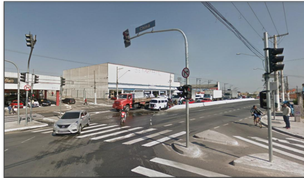
Foto 20: Av. Av. Marechal Tito x Viaduto da China
