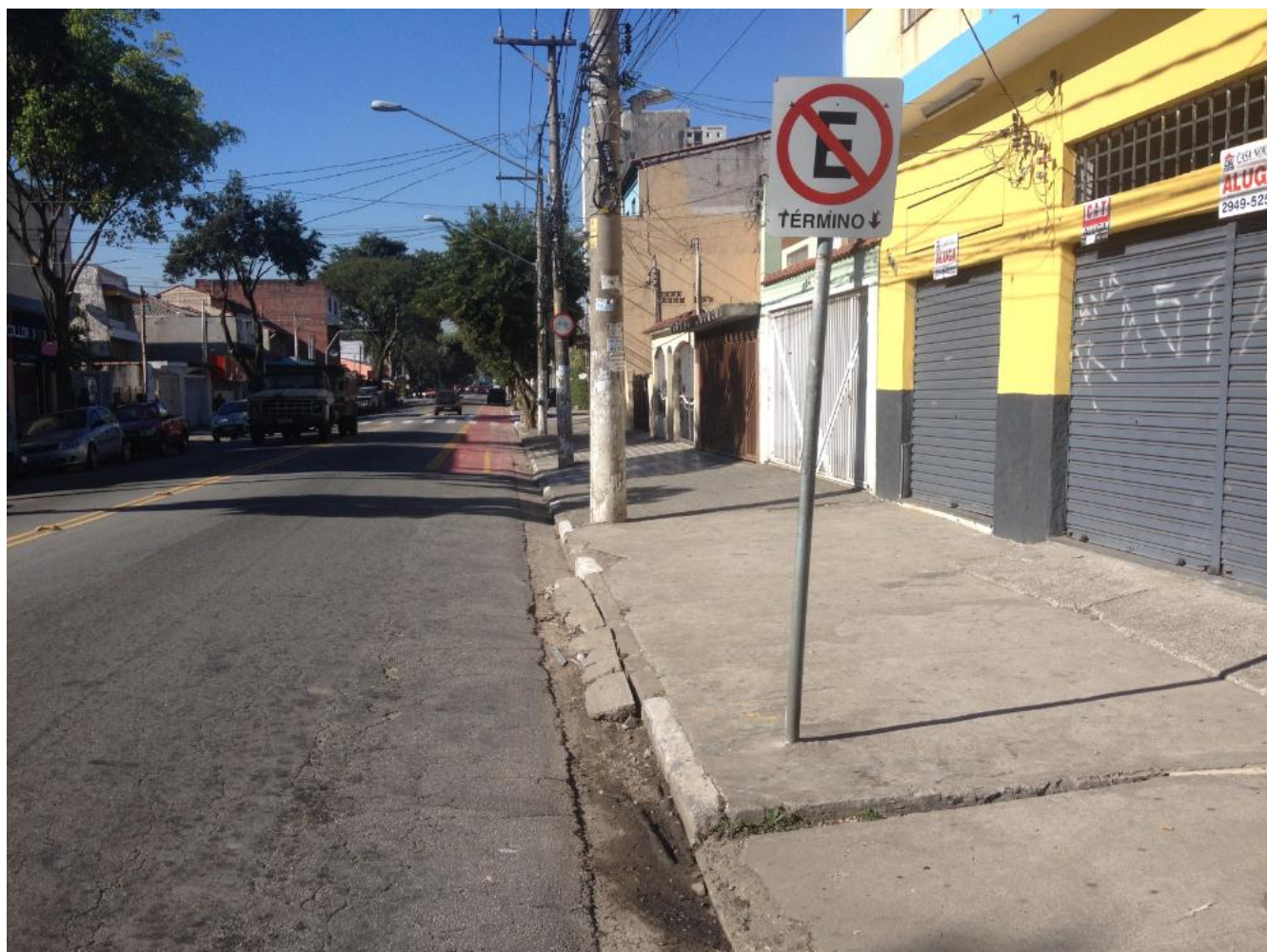
Foto 17: Ciclofaixa interrompida na altura da barreira eletrônica na Av. Edu Chaves
