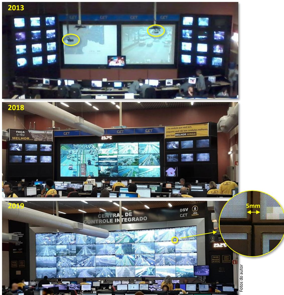
Figura 222. Central Bela Cintra em três momentos e detalhe das bordas entre módulos.
