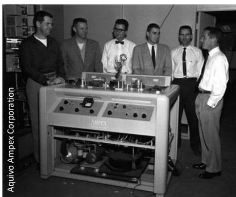
Figura 69. Gravador Ampex VRX-1000. Os rolos de fita ficavam na posição horizontal, sobre o gabinete.
